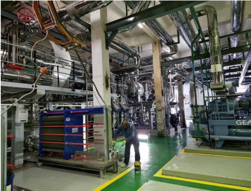
Bild 4: CaaS-Projekt – Ammoniak-Kälteanlage in einer Milchverarbeitungsanlage von Clover, Südafrika
