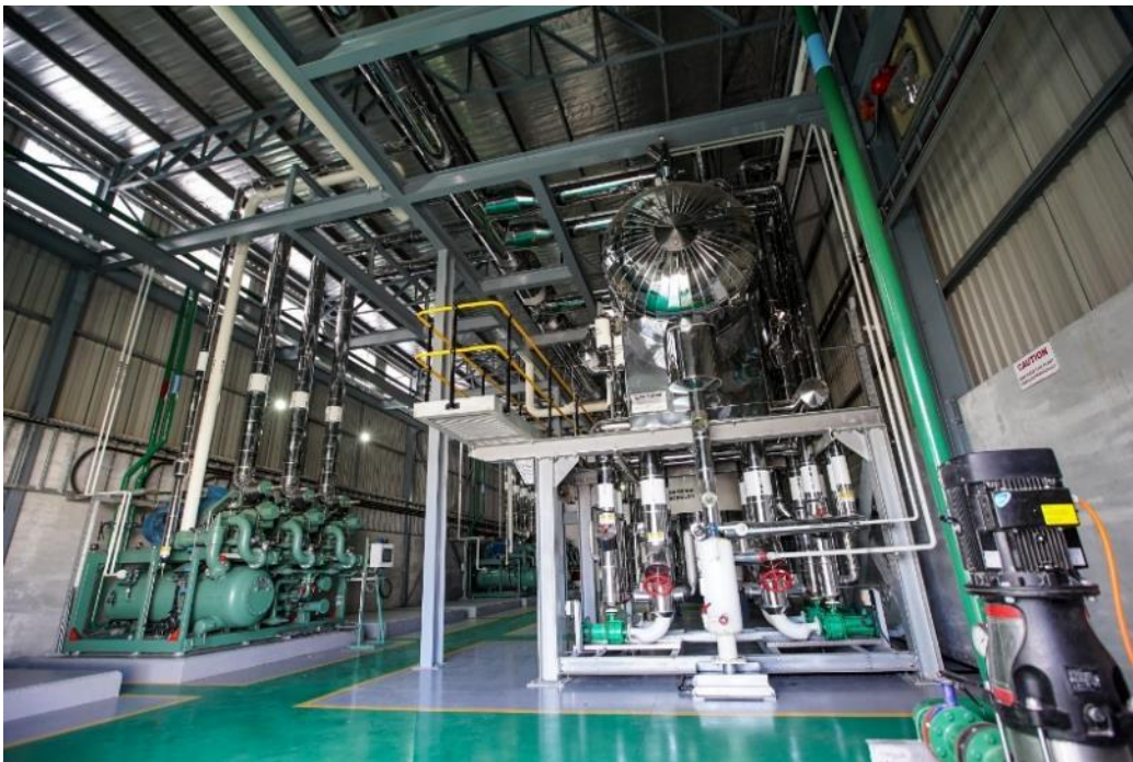
Bild 3: CaaS-Projekt – Ammoniak-Kälteanlage in einer Geflügelproduktionsanlage von Sovereign Foods, Südafrika Foto: Energy Partners
